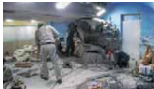
▲ 改修工事の様子
