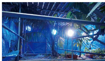
▲工事足場と保温用のシートに囲まれた植物
