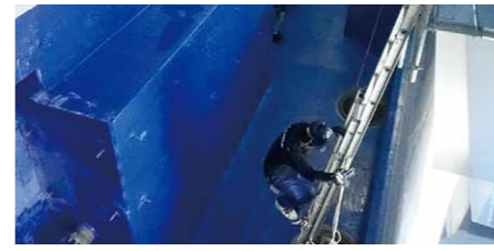
▲「サンゴ礁の庭」防水補修後の水そう内
